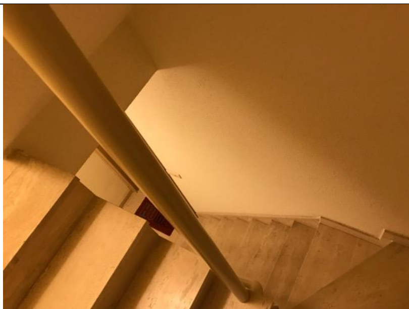
Foto 20 : de trappenhall in cementpleister
