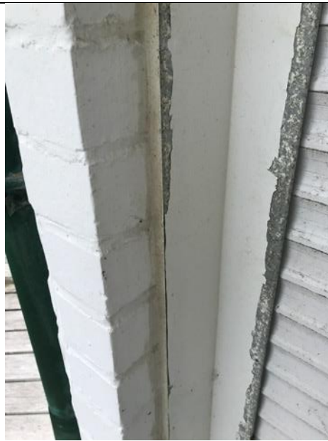
Foto 21 : dichtingsvoegen in silicone
